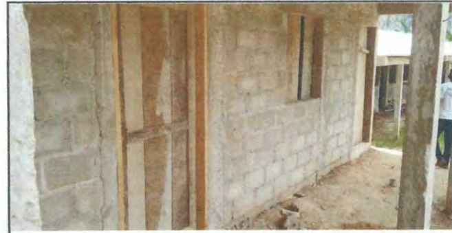
Foto 6: Se observa la falta de repello de paredes en lado interior y exterior del módulo 1.
